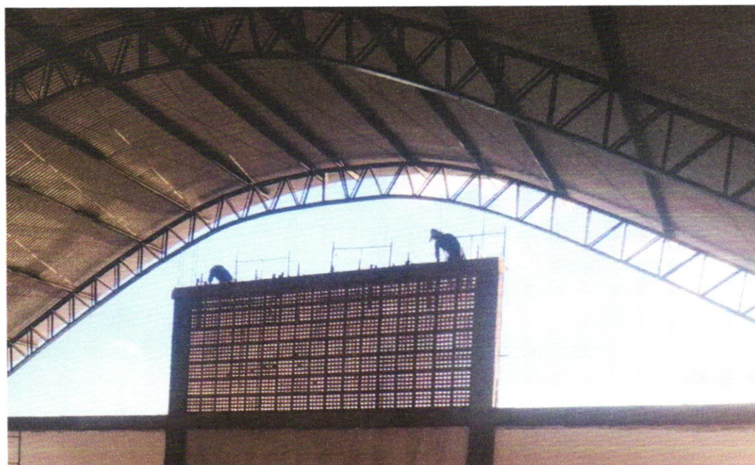
IMAGEM 04 - Telhamento com telha metálica em chapa de aço galvanizado natural ondulada e=0,5\text{mm}
