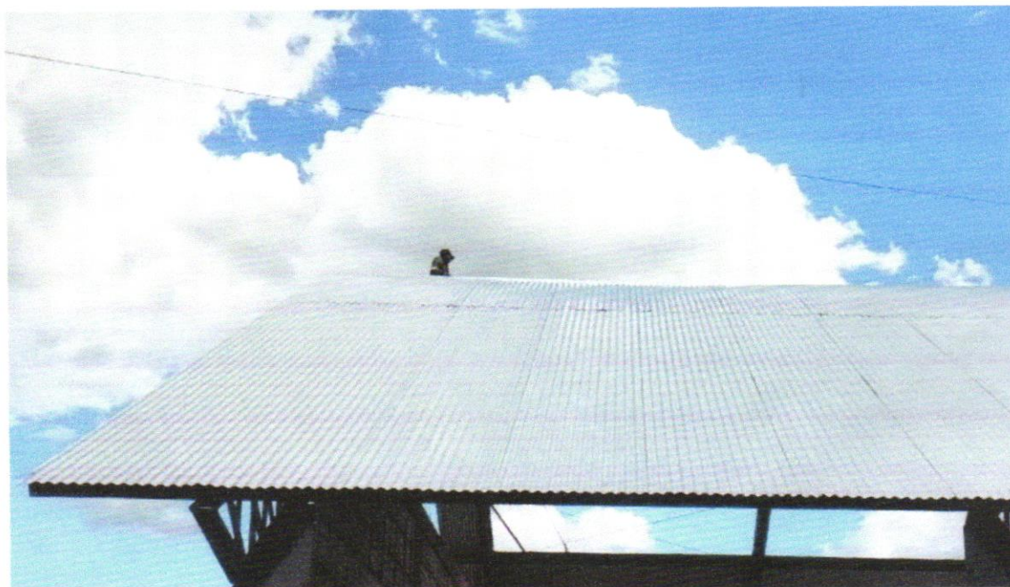
IMAGEM 03 - Telhamento com telha metálica em chapa de aço galvanizado natural ondulada e=0,5\text{mm}
